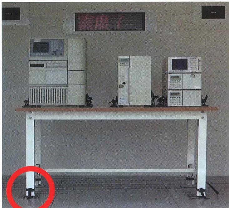
○作業台脚部の床面にマット付き耐震金具を設置、耐震金具と作業台フレームをベルトで取付ける簡単設置
